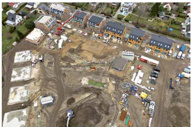
Dezentrale Energiewende in progress: 84 Wohneinheiten entstehen hier.
