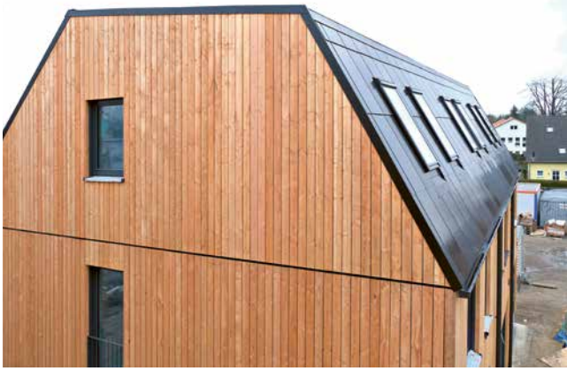
Fügt sich ins Bild: Nachhaltige Energieerzeugung trifft Holzbauweise.
