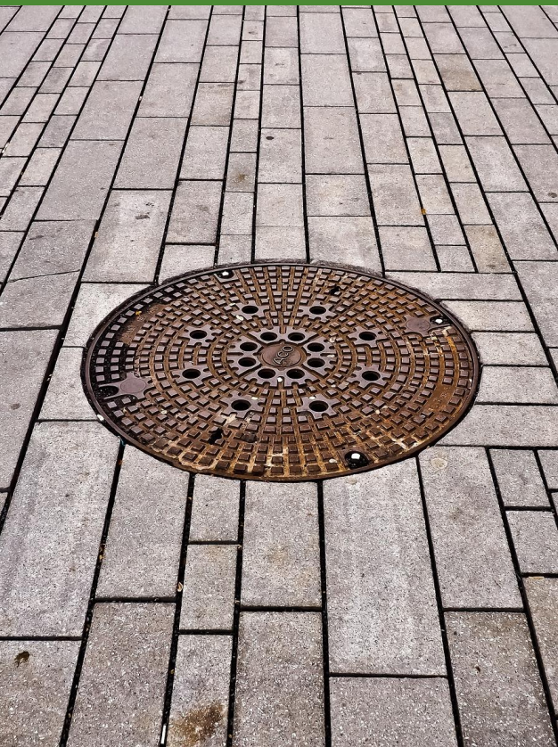
Wärme aus Abwasser
