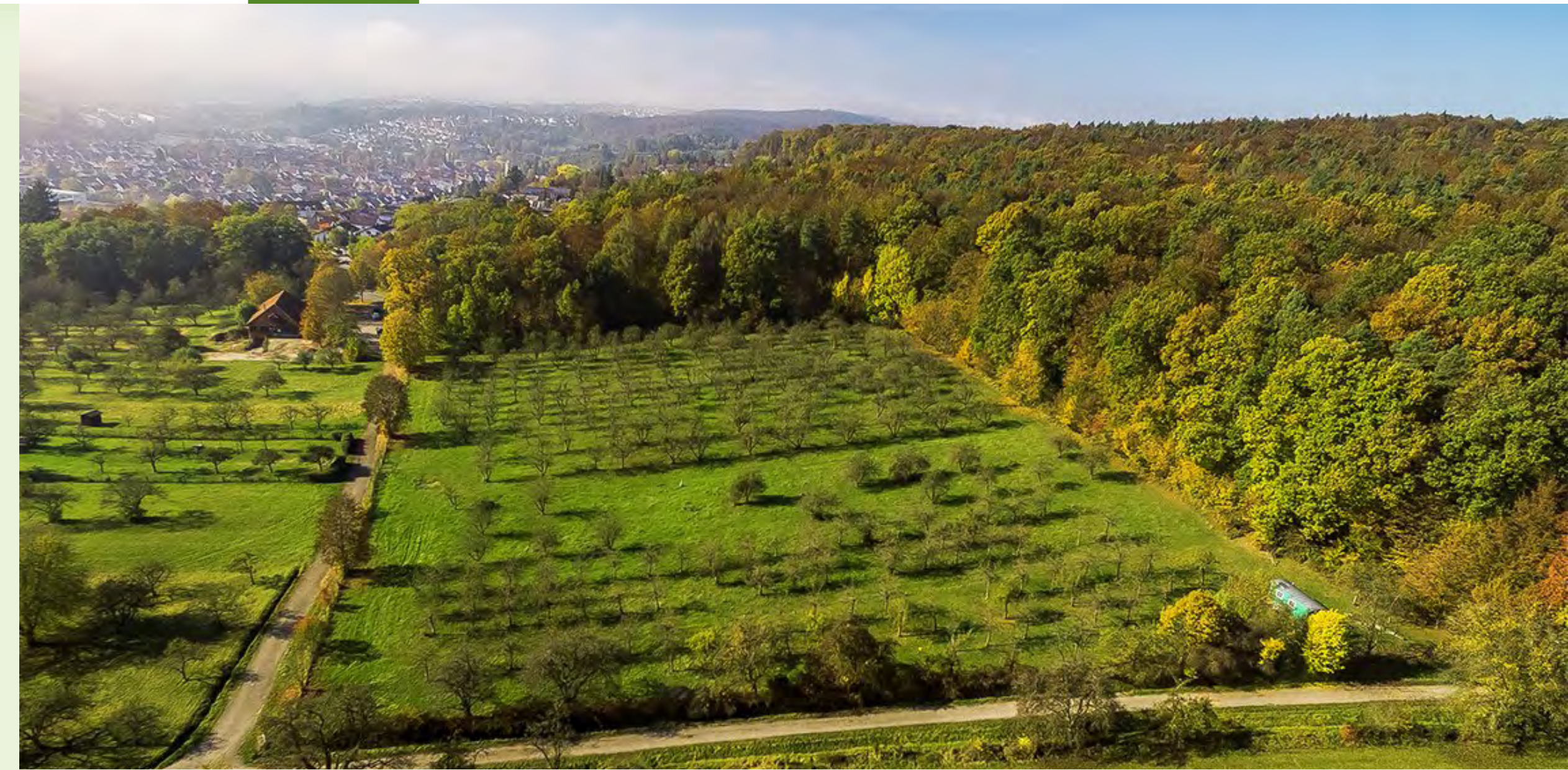
Reichenbach an der Fils – kaltes Nahwärmenetz. Die 3.900 m 2 Fläche für das Kollektorfeld sind seit der Verlegung im Frühjahr 2019 wieder uneingeschränkt landwirtschaftlich nutzbar.
